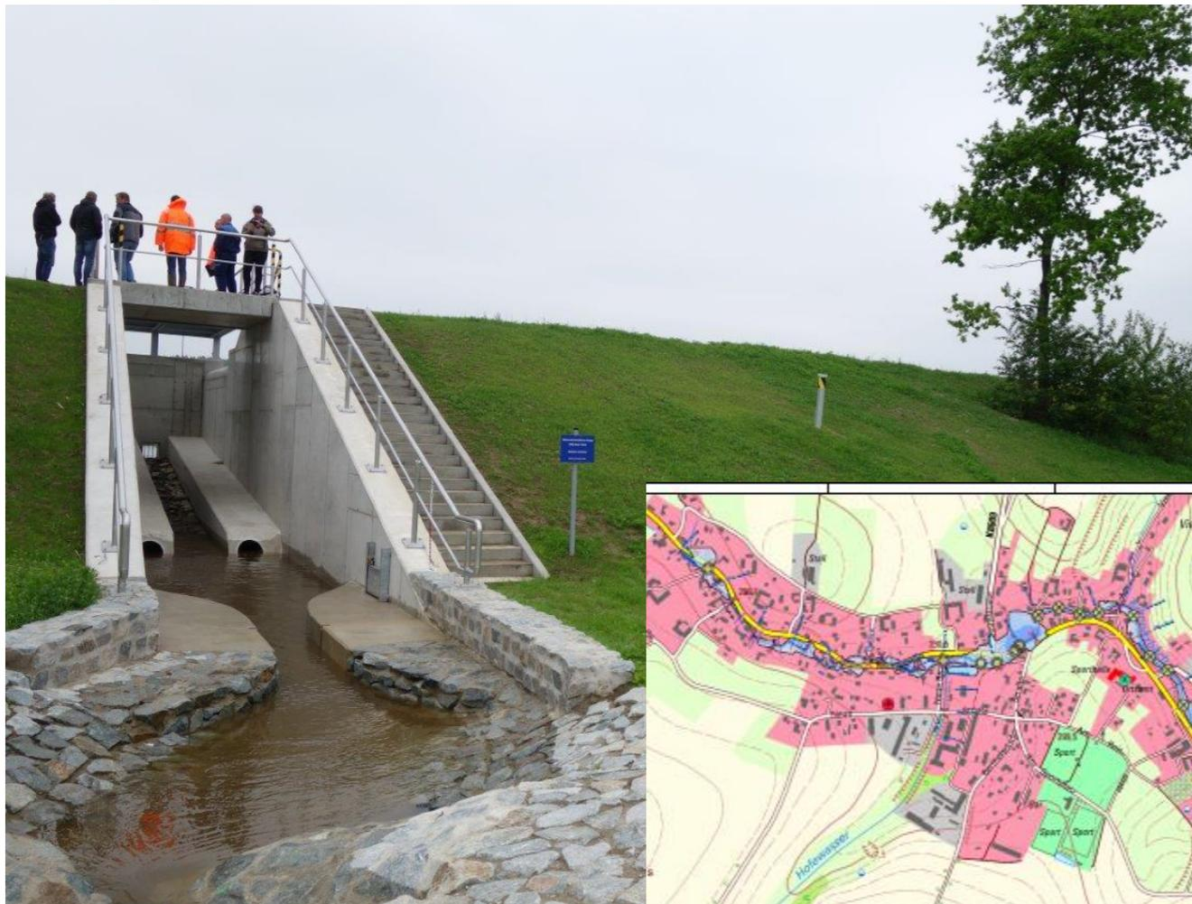
Das Hochwasserrückhaltebecken „Großer Teich“ trägt maßgeblich zur Erreichung Schutzzieles HQ100 in der Ortslage bei
