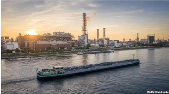
BASF-Anlagen am Rhein in Mannheim.
